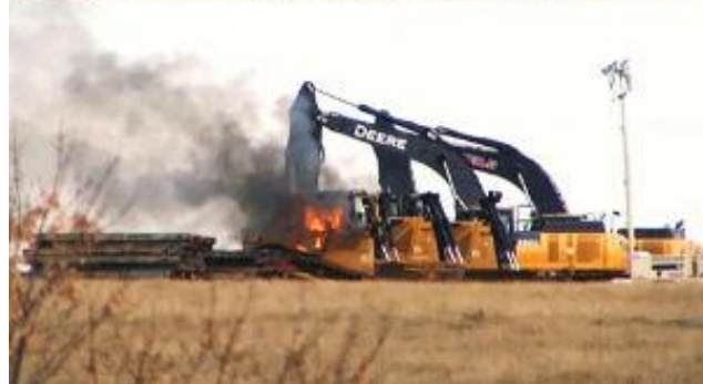
Sabotaż budowy rurociągu DAPL
